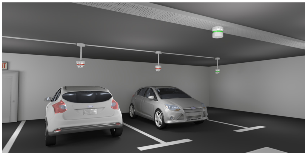
Fig. 5 Un indicatore SBIPILED associato a tre sensori SBPSUSL
