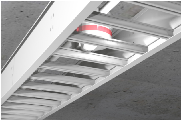
Le capteur est influencé par l'obstacle
