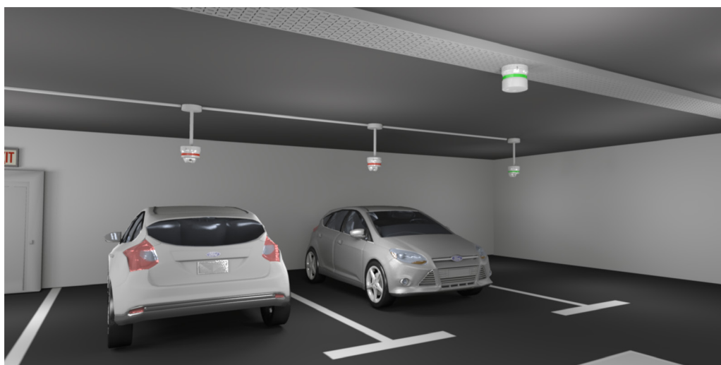
Fig. 5 Un indicateur SBPILED associé à trois capteurs SBPSUSL
