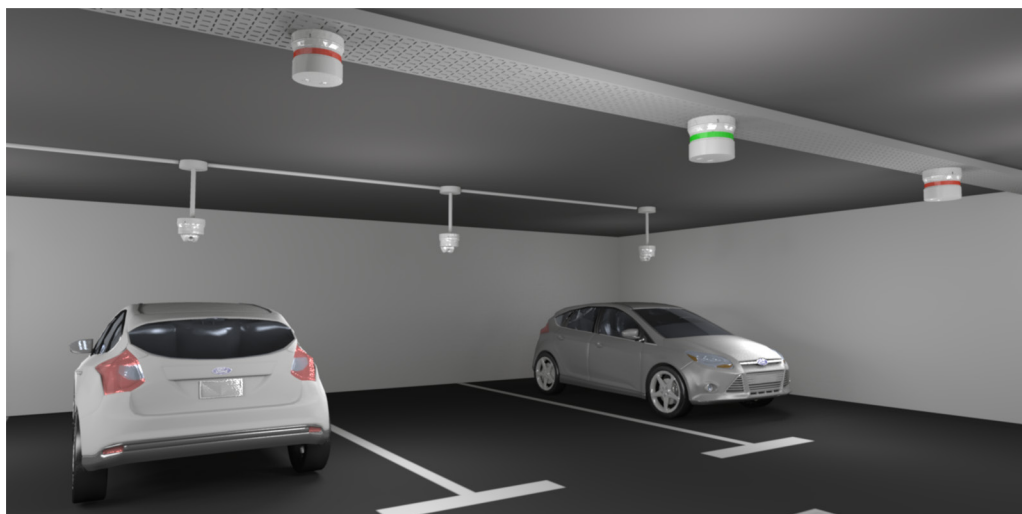
Fig. 4 Un indicateur SBPILED associé à chaque capteur SBPSUSL
