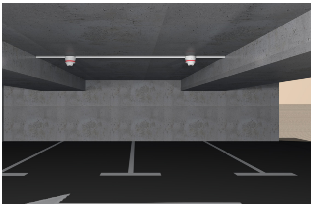
L'obstacle est trop proche des capteurs
