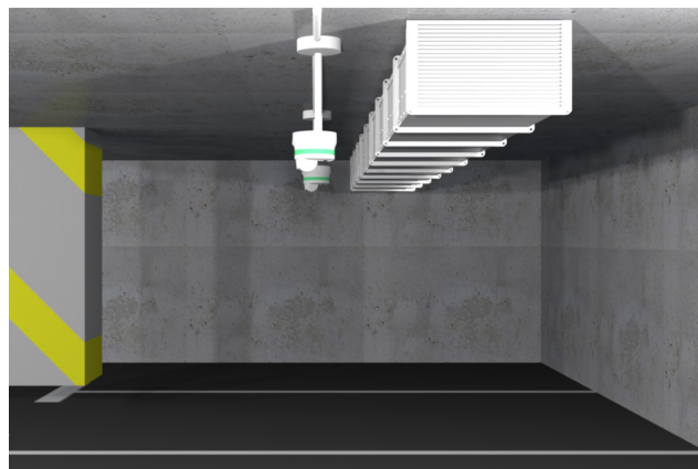
Posicionar SBPBASEA por lo menos a 5 cm por debajo del obstáculo
