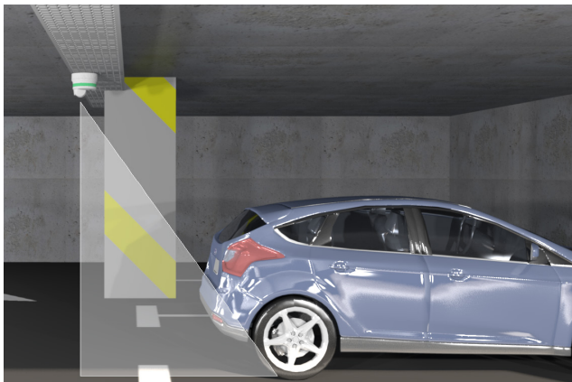
SBPBASEA y el sensor están mal montados en el lado izquierdo de la bandeja de cables
