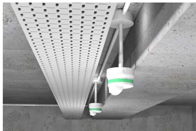
Positionieren Sie den SBPBASEA mindestens 5 cm unter dem Hindernisse
