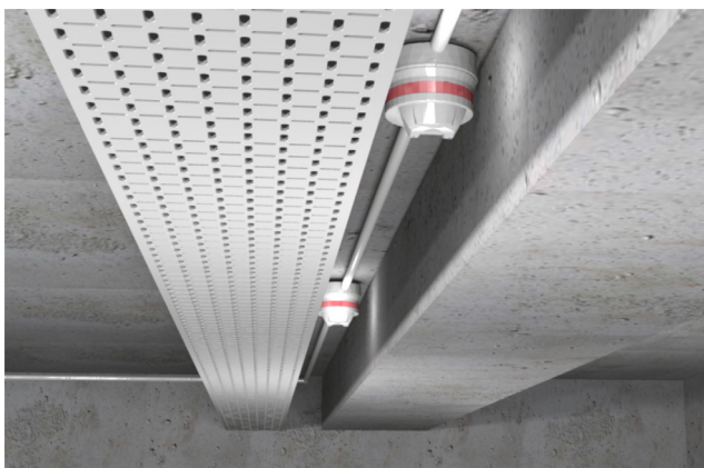
Der Sensor wird durch das Seitliche Hindernisse blockiert
